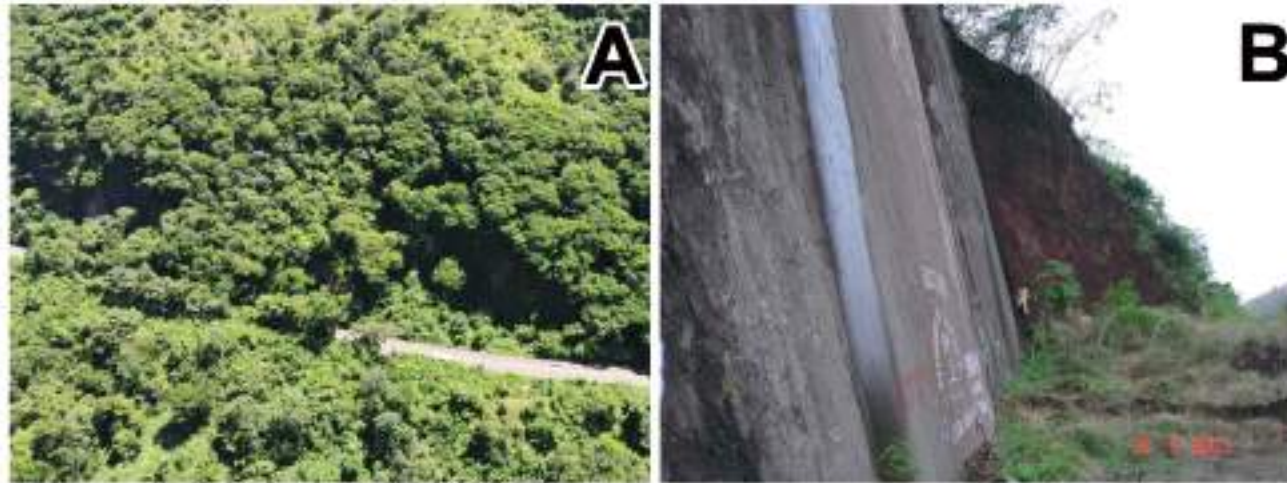
Figura 3. Escarpe de falla de Chirilagua. A) Vista panorámica del estado actual de los segmentos visibles del escarpe de falla siendo protegido por la vegetación. B) Escarpe visible de la falla de Chirilagua en 2007. Obsérvese el material de talus de color rojizo que cubrió y protegió la falla. Fotografía: A) Carles Fernández B) Walter Hernández.
